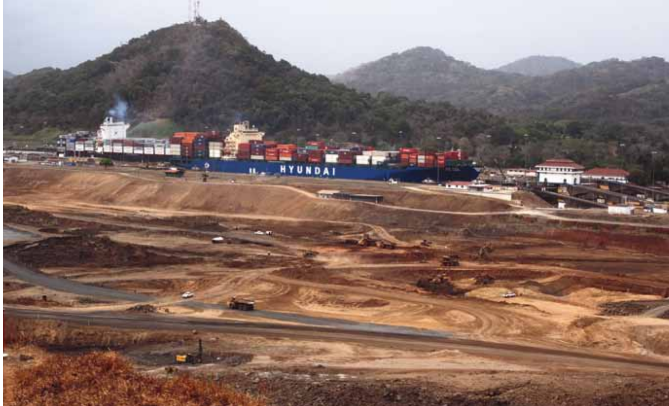
De nya slussarna byggs vid sidan av de gamla.
