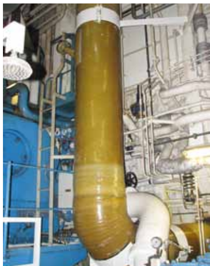
Genom detta rör evakueras skrubbern.
