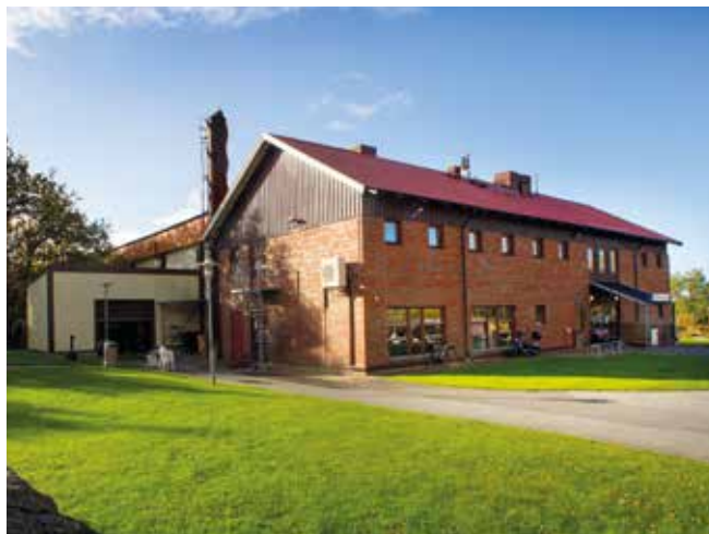
Även om mycket förändrats i Göteborg sedan Rosenhill byggdes, ligger anläggningen fortfarande strategiskt placerad nära flera hamnområden.
